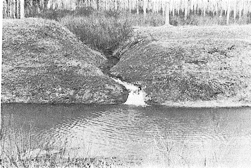
Sl. 1. Erozija na utoku detaljnog kanala IV reda u kanal Biđ
