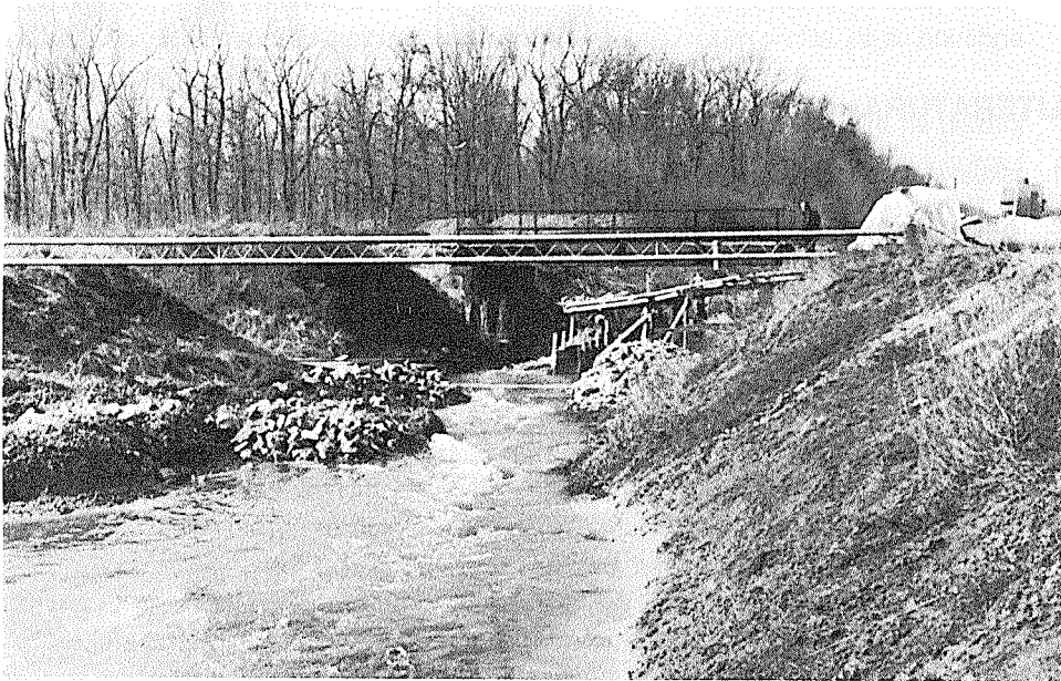
Sl. 2. Sanacija erozionog djelovanja iz kanala Jošava.
